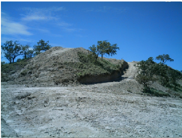
Foto N°18: Vista de un camino interno realizado
