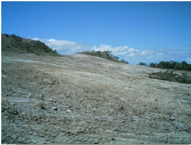
Foto N°17: Vista de los movimientos de tierra y de de los trabajos de nivelación que se realizaron
