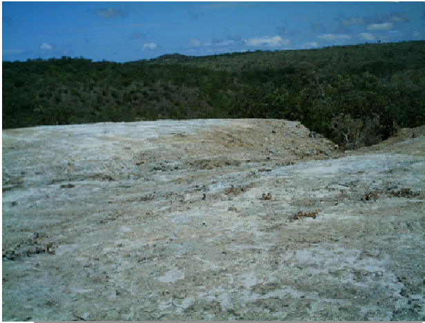
Foto N°16: Vista de los movimientos de tierra y de de la topografía del terreno, con el río Liberia al fondo.
